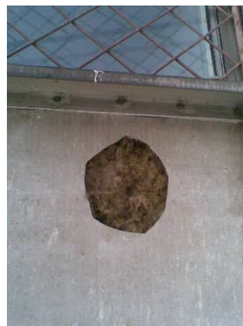
Foto. 2.4.-2. Elewacja warstwowa (szkło hartowane, pustka powietrzna, płyta azbestowo-cementowa, wełna mineralna) (Plan, 2007)
