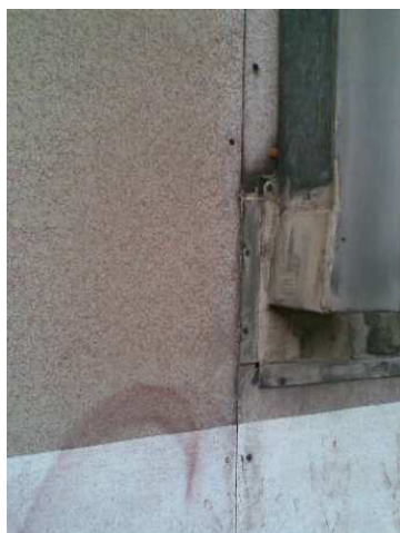
Foto. 2.4.-5. Elewacja z płyty azbestowo-cementowej - prasowana płaska okładzinowa (Plan, 2007)
