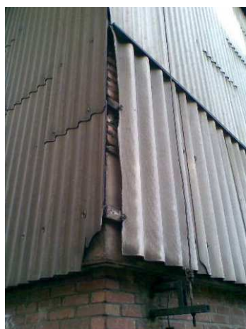
Foto. 2.4.-3. Elewacja z płyty falistej, płyty azbestowo-cementowej (Plan, 2007)
