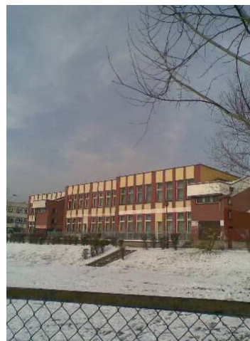
Foto. 2.4.-6. Elewacja z płyty azbestowo-cementowej płaskiej, malowana (Plan, 2007)
